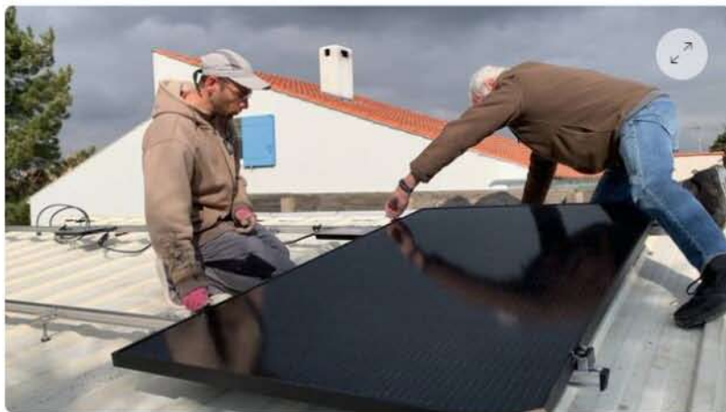
La pose d'un panneau photovoltaïque par François Gaboriau et un membre des Survoltés. | OUEST-FRANCE
